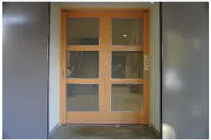
収蔵庫扉修繕
