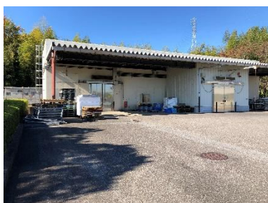
水産冷蔵庫棟
