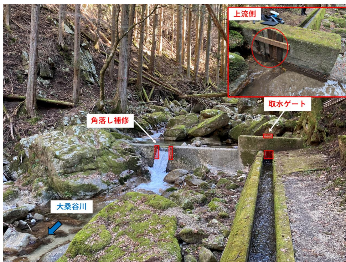
既存取水堰の改修
