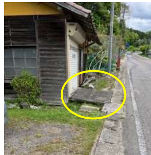
土間コンクリート（解体）
