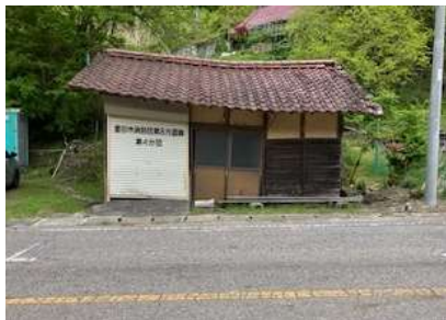
詰所格納庫（解体）
