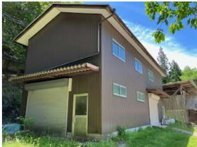
鉄骨造倉庫（残置）
