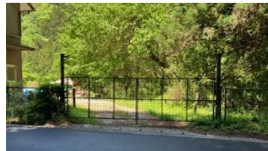
門扉・フェンス（残置）
