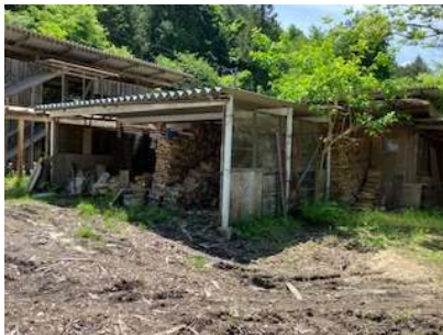
鉄製屋根・柱
