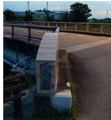
<盗難後の状況>
