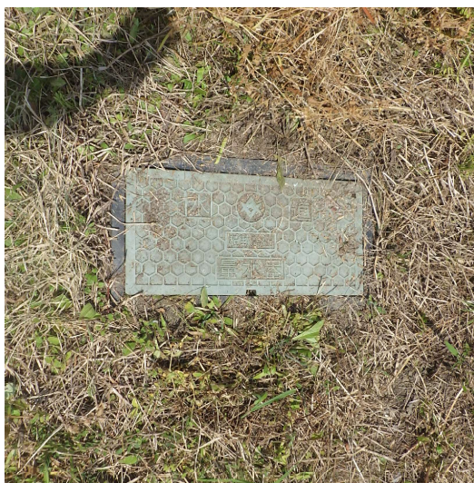
④給水メーターボックス（残置）
