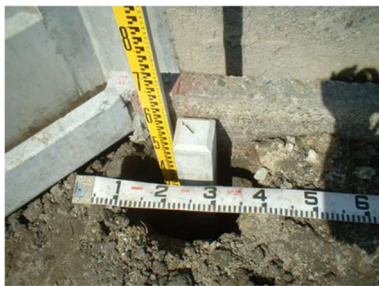
コンクリート杭
