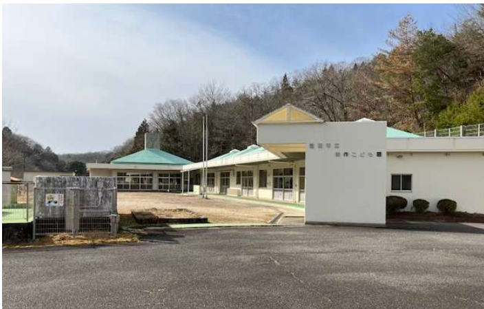
駐車場から撮影
