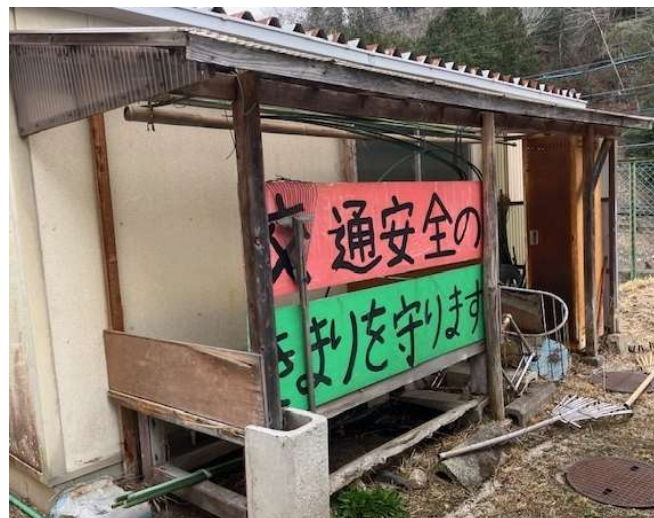
裏側の木製柱とトタン屋根
