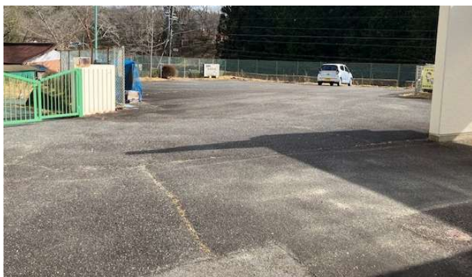
⑧駐車場（解体）※門扉から敷地内に長さ5 m程度（約3.5 m）は残置
