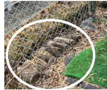
フェンス際地表面ブロック
