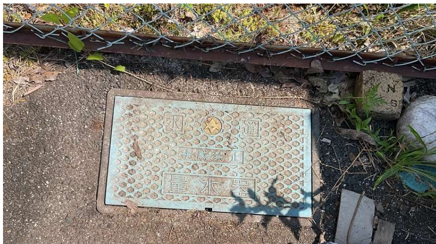
㊦給水メーターボックス（残置） ※メーターから敷地側は撤去
