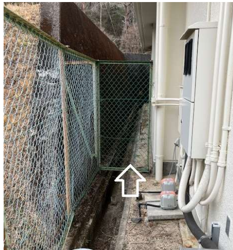
敷地西側フェンスとの接続部分のフェンス
