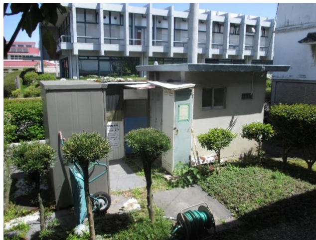
⑥ (C 倉庫 (旧便所))
