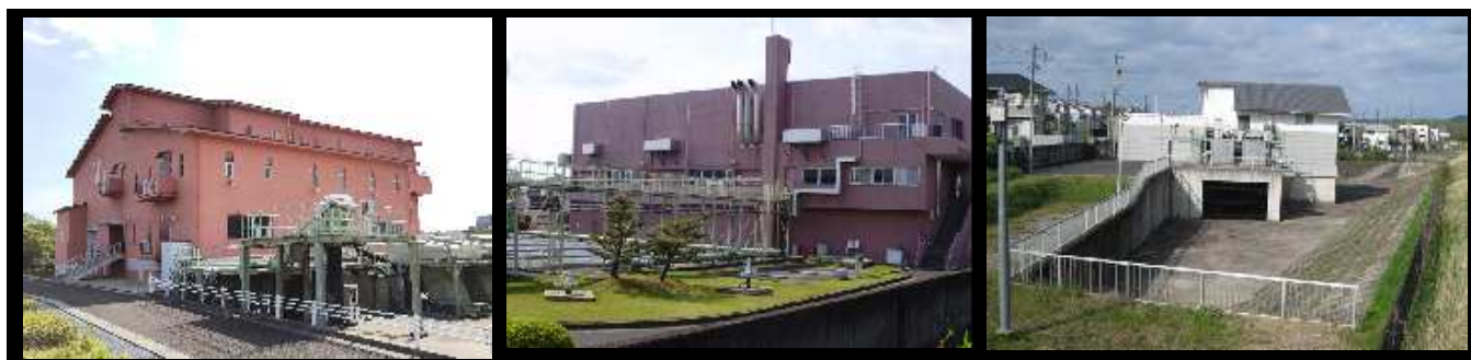
【豊田市内雨水ポンプ場】
