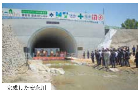
完成した安永川
