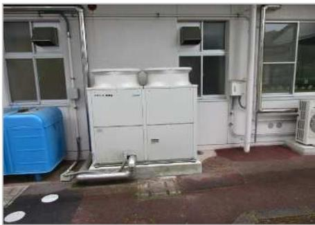
空調機用室外機本体に著しい腐食、損傷、異常振動、異音等はないか。
