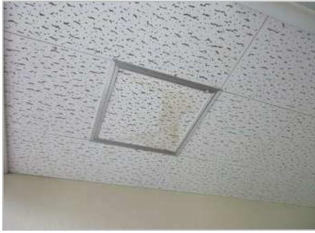
点検口本体及び枠にずれ、変形、腐食等はないか。
