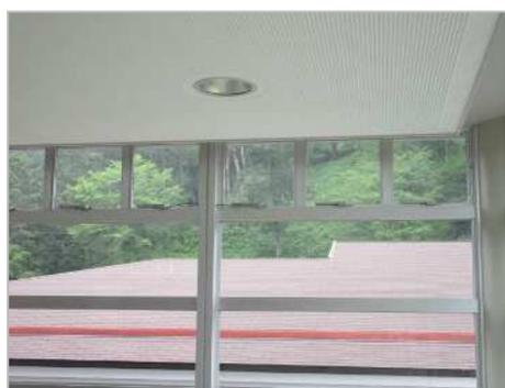
排煙口、排煙窓が障害物等により作動が妨害されていないか。故障等により機能は損なわれていないか。
