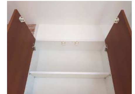
吊戸棚等の地震対策措置
