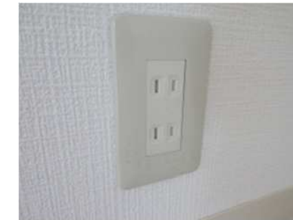
コンセントの感電防止措置 (シャッター付きコンセント等の設置)
