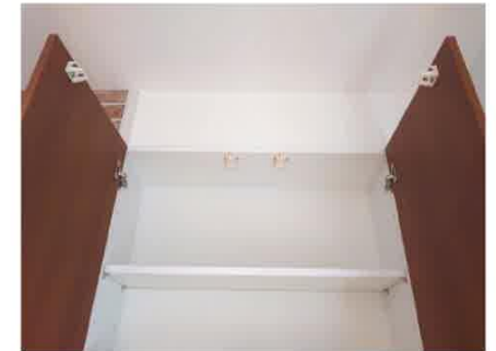
吊戸棚等の地震対策措置
