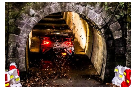
伊世賀美隧道 (旧伊勢神トンネル)
