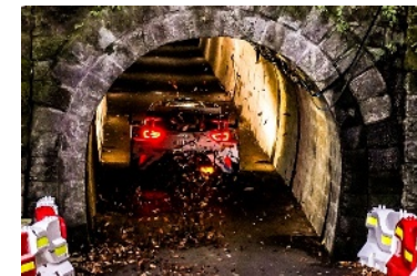
伊世賀美隧道 (旧伊勢神トンネル)
