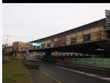
■足場による点検
