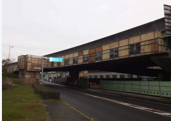
■ 足場による点検
