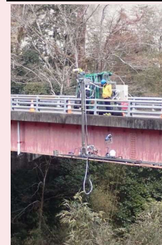
■ 橋梁点検支援ロボット
