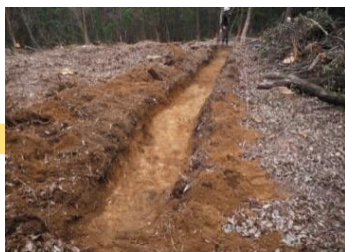
【⑤筋掘り完了後】
