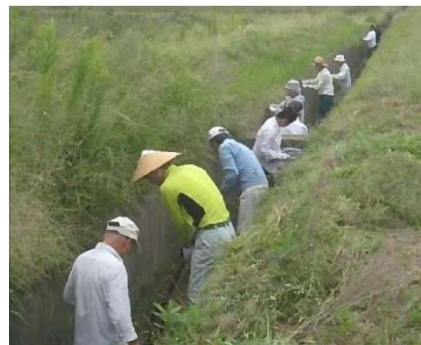
排水路の清掃（宮口新田農地・水保全会）
