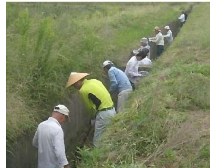
排水路の清掃（宮口新田農地・水保全会）
