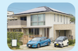
スマートハウス 2011/ システム試験運用
