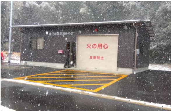
エアコン室外機の盗難状況 (現場外観)
