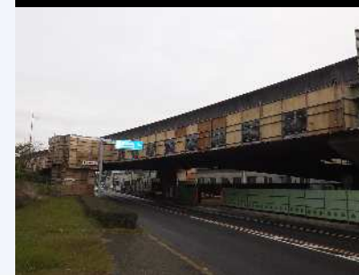
■足場による点検
