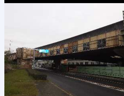
■足場による点検
