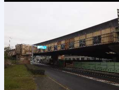
■足場による点検
