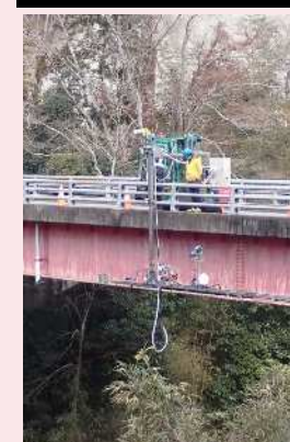
■橋梁点検支援ロボット
