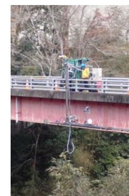
③ 橋梁点検支援ロボット
