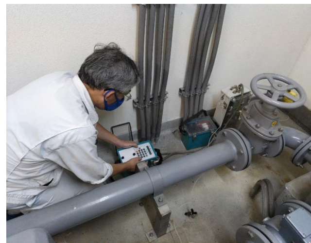
装置提供事業者による機器校正の様子
