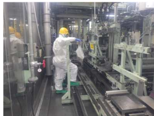
手解体の様子 (イメージ)
