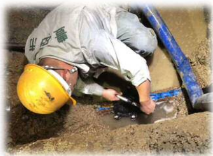
漏水修繕の様子
