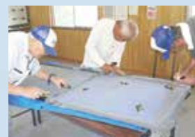
網戸の張り替え作業
