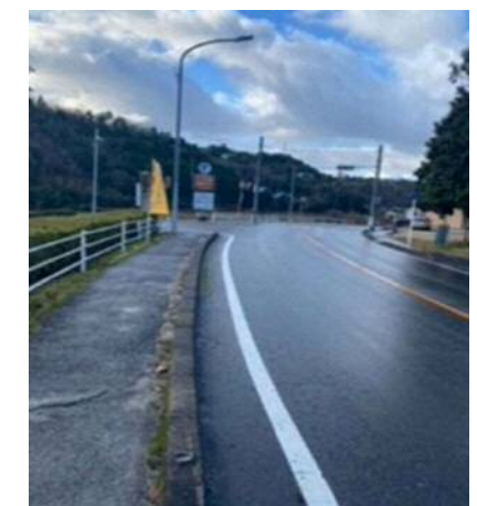
④出口付近（御作上方面から）
