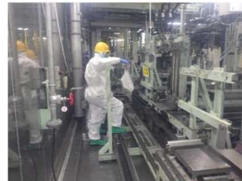
手解体の様子 （イメージ）
