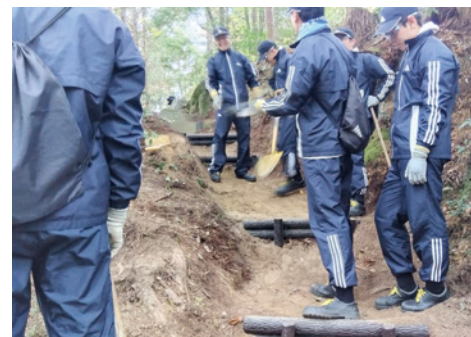
▲歩幅を考えながら、階段を設置
