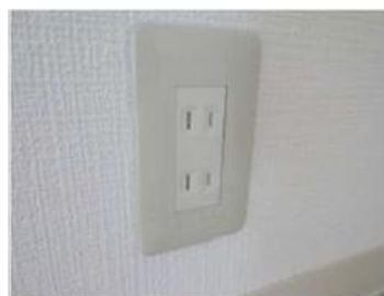
コンセントの感電防止措置 (シャッター付きコンセント等の設置)
