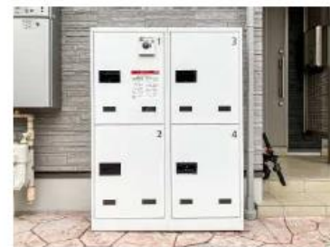
宅配ボックスの設置
