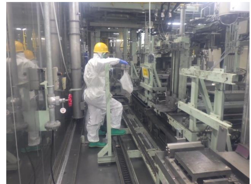
写真 遮へいフード内での作業
