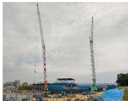
博物館建築工事
