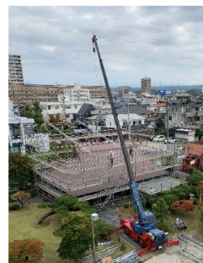
旧平岩家移築工事
