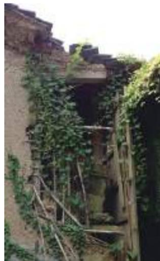
▲瓦の劣化から生じた雨漏りとその後の壁面崩落や腐朽など
