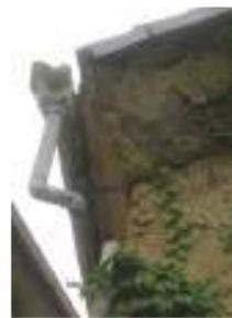
▲雨樋の機能不全から生じた壁面の崩落
