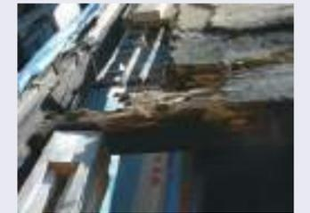
▲梁の腐朽状況(修理工事中)
