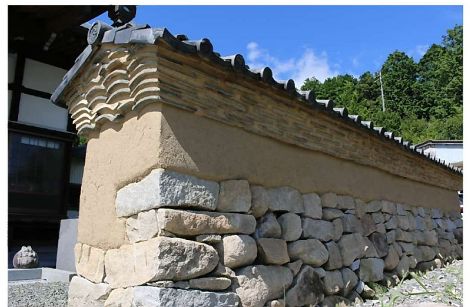
▲完成した土塀
