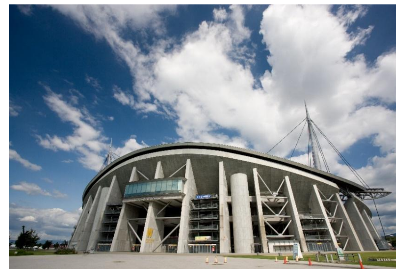
国内最大級の球技専用スタジアム「豊田スタジアム」
