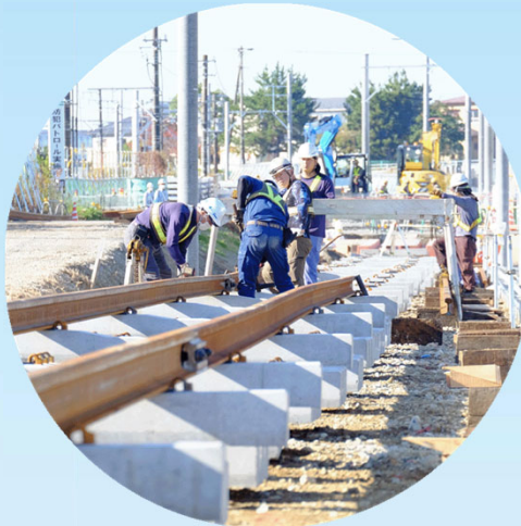
レールの設置
