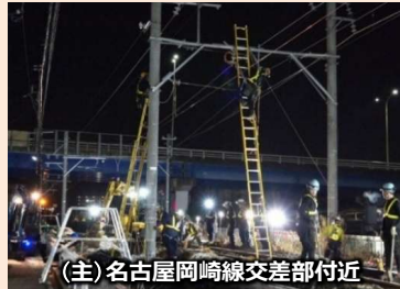
(主)名古屋岡崎線交差点付近
