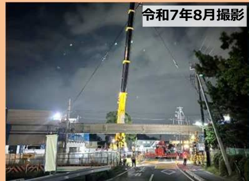
【夜間】桁架設工事（三河八橋8号踏切）
