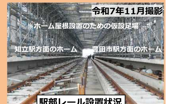
※ホーム屋根設置のための仮設足場 知立駅方面のホーム 豊田市駅方面のホーム 駅部レール設置状況
