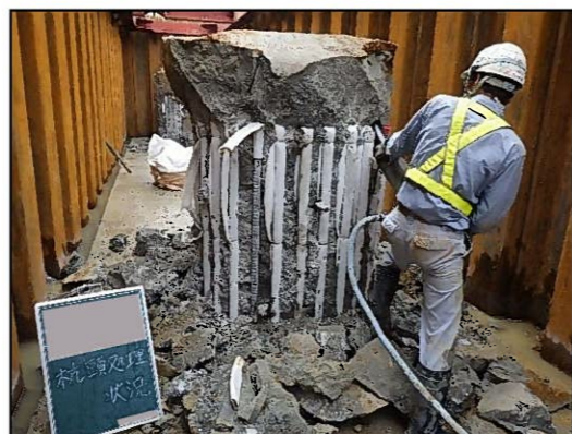
コンクリートの加工（他事例）
