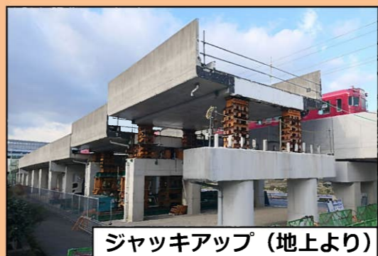
ジャッキアップ機械
