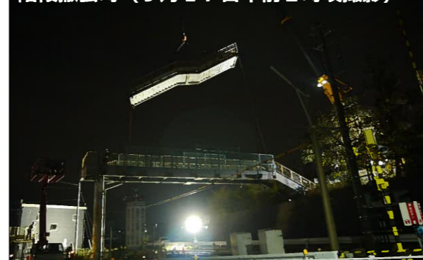
階段撤去時（9月17日午前2時頃撮影）
