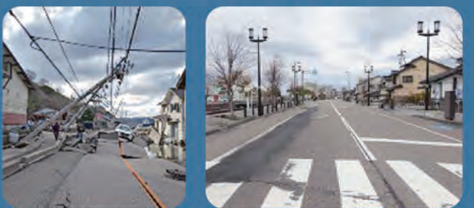
▲倒壊した電柱（写真左）と被災後の無電柱化路線（写真右） 【出展】国土交通省HP
