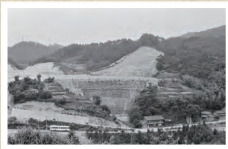
松平高校造成工事中(1969年)
