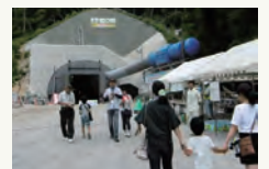
平成30年:松平トンネル工事現場見学会
