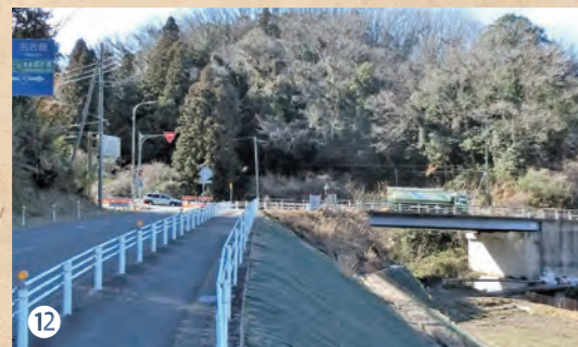
▲ まもなく架け替え工事が始まる大内橋 (2021年1月撮影)
