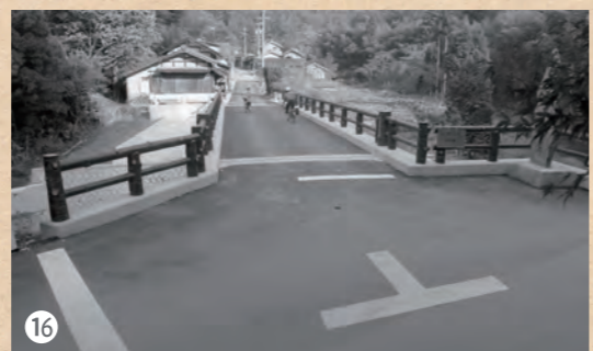
▲ 王滝町仁王川に架かる築山橋完成
