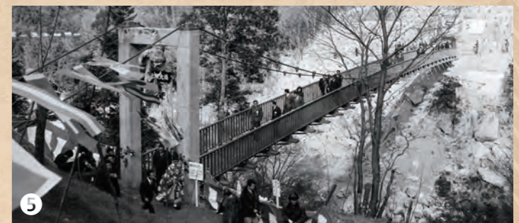
▲ 王滝渓谷に開通した中之瀬大橋
