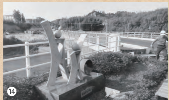
▲ 岩倉町と中垣内町を結ぶ完成間際の巴新橋
