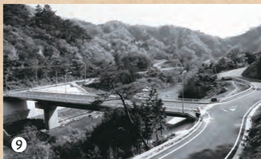
▲ 王滝町と穂積町を結ぶ滝穂橋完成
